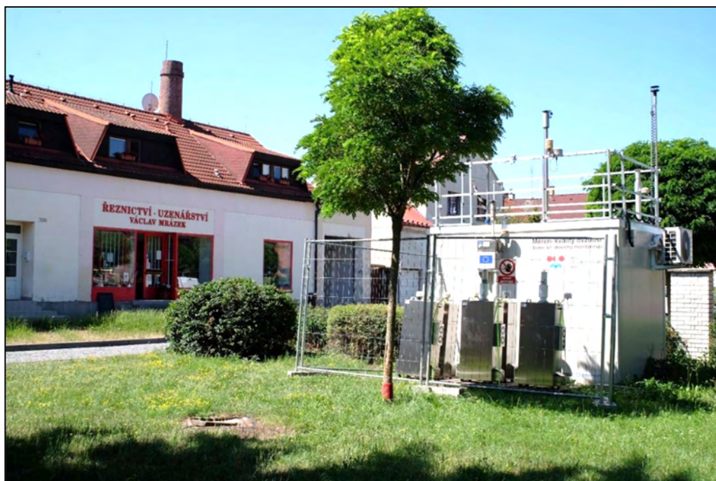
Obrázek 2 Fotodokumentace měřicího místa Kladno-Švermov – pohled od SV
